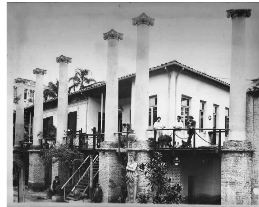
Imagem 2 – Vila Itororó em construção, s/ data, Vila Itororó Canteiro Aberto, Arquivo Milu Leite
